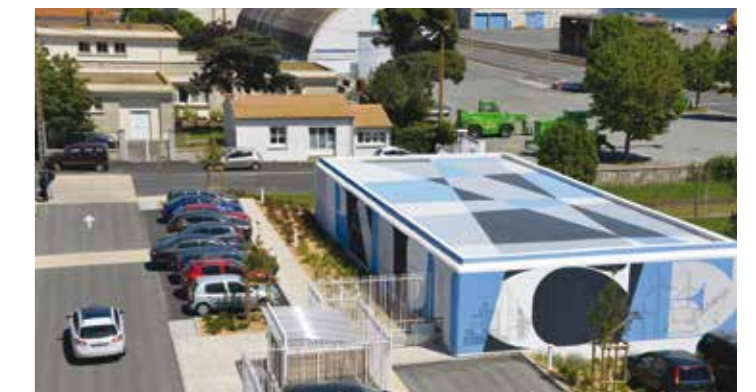
Le blockhaus jouxtant la Maison du Port aux couleurs d'une fresque dédiée au quartier de La Pallice
