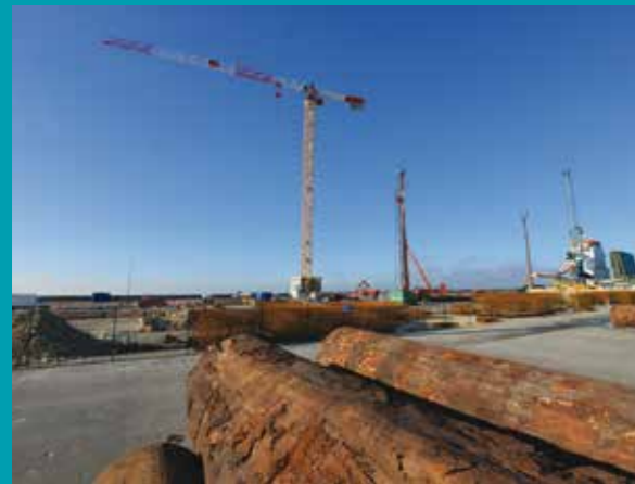
Construction du silo Socomac sur le terminal de Chef de Baie
