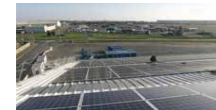
Solarisation des hangars portuaires
